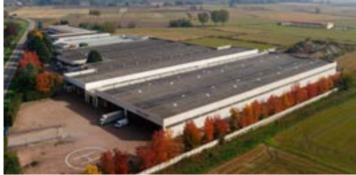
La sede Ghibli & Wirbel de Dorno: desde 1968, 40 000 metros cuadrados destinados a la investigación y al mantenimiento de la calidad.
